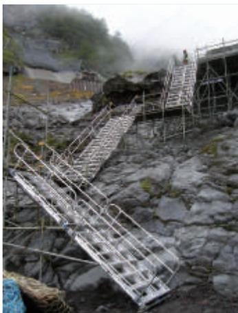
●さまざまな傾斜角度に応じてステップの角度が自在に調整できるアルミ合金製ユニット式階段です。
